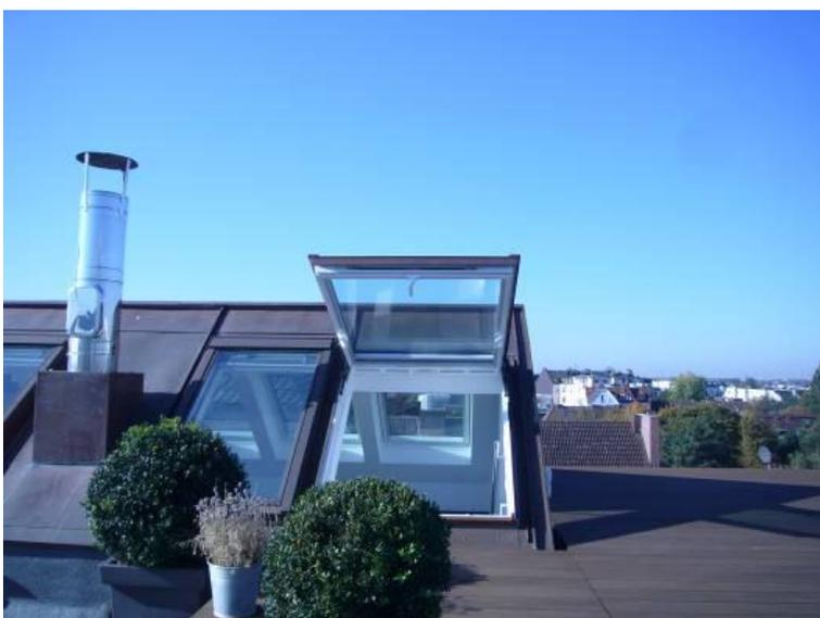
*Die Eindeckrahmen der Dach-Schwingfenster sind aus Kupfer. Sie entsprechen aus gestalterischen und technischen Gründen dem Rinnensystem, der Bekleidung von Lichtdach samt Giebelabdeckungen.*
