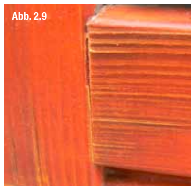
Feuchtigkeitsschaden durch aufgerissene Holzverbindung
