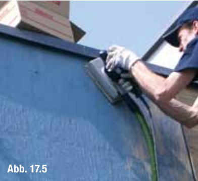
maschinelles Abschleifen der Altbeschichtung
