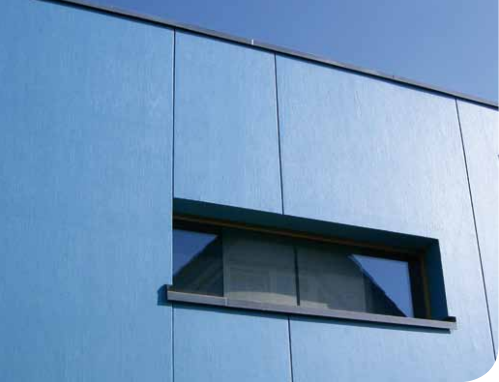
Abb. 17.6: Endbeschichtung 2-fach mit Cetol Wetterschutzfarbe
