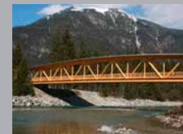
Holzbrücke in Weissenbach (Österreich); eine Konstruktion aus Brettschichtholz, für die ein physikalischer Oberflächenschutz durch Beschichtung nicht erforderlich ist.
