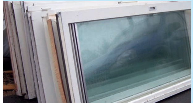
Zwischenlagerung von Altfenstern an der Baustelle zur späteren Wiedergewinnung von Wertstoffen
