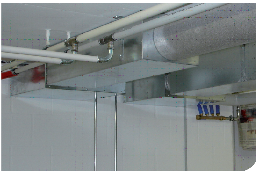
Zwei blaue Montageplatten sind auf die hölzerne Verschalung genagelt und mit den ComfoTube-Rohren verbunden (oben), welche später mit Flüssigbeton bedeckt werden. Sobald die Verschalung demontiert ist, können die Verteilkasten auf die Montageplatten, dann an der Decke sichtbar, geschraubt werden. Rechts sind die beiden Verteilkästen für die Zu- und Abluft sichtbar, beide verbunden mit den Schalldämpfern davor.
