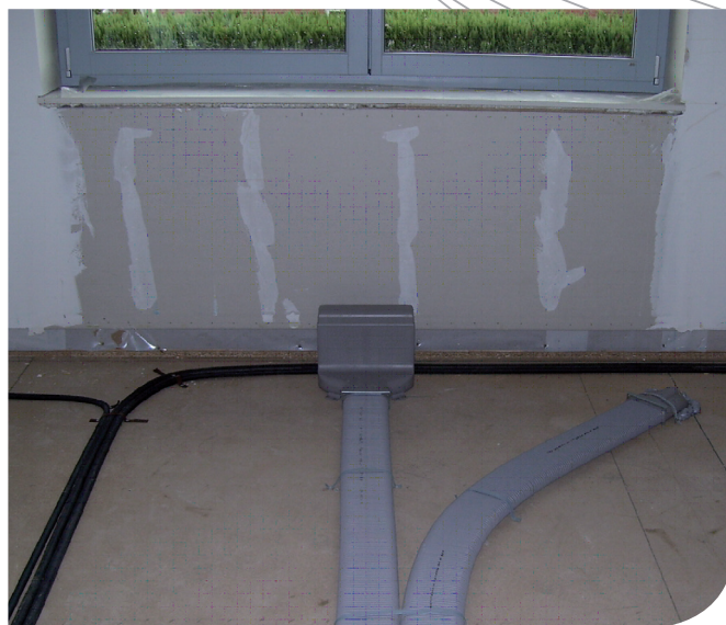
eingelegt werden können, werden in Norddeutschland Hohldeckenelemente verwendet, auf die flache ComfoTube-Rohre in der Trittschalldämmschicht verlegt werden.
