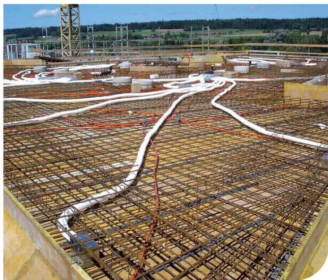
Jedes Land hat seine eigenen Bauweisen. Während in der Schweiz und in Österreich Betondecken meist in vor Ort gebaute Holzschalungen gegossen werden, in die die ComfoTube-Rohre
