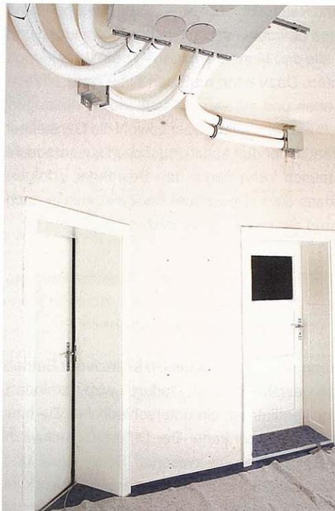
Im Sinne eines optimalen Betriebs der Lüftungsanlage sollten bei der Montage keine Leitungen aus dem Verlegevorschlag weggelassen werden. Denn dieser beruht auf einer Luftmengenberechnung auf Basis des Grundrisses und stellt die ausreichende Frischluftversorgung sicher. Luftauslässe hingegen können individuell platziert werden
